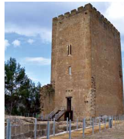
Vista exterior de la torre de Navardún
