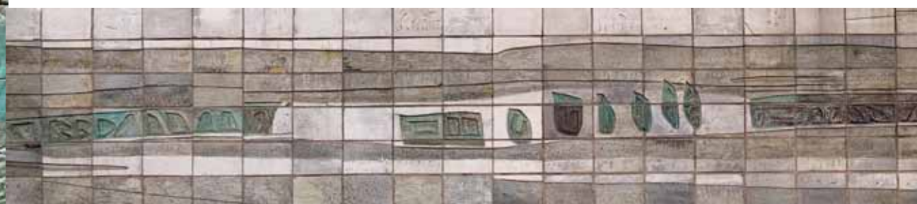
Friso de la fachada del edificio Ibercaja / E. A. Cuní
