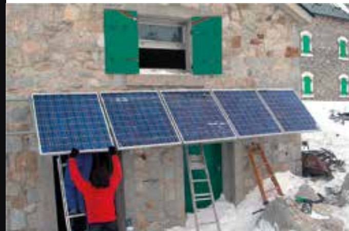
Colocación de placas solares en La Renclusa
