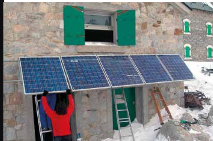
Colocación de placas solares en La Renclusa
