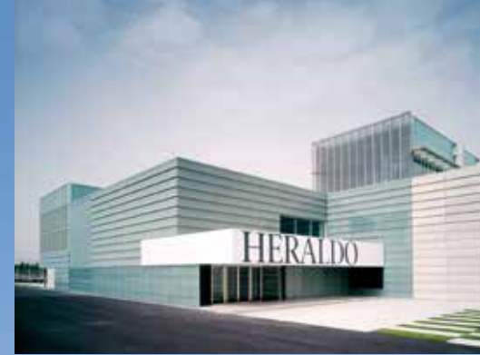
Rotativa de Heraldo de Aragón, Villanueva de Gallego. Arquitectos y fotos: J. Colmenares – M. D. Vilata – S. Colmenares – L. Colmenares
