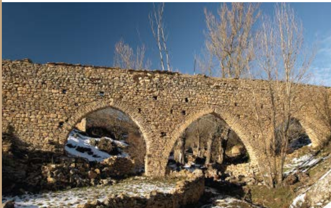
Acueducto sobre el río Penillas. Camarillas FOTO JAVIER ROMEO
