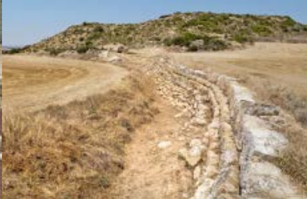
A 2,5 km de distancia, la presa de Cubalmena era capaz de almacenar 30.000 m 3 de agua para abastecer a la ciudad
