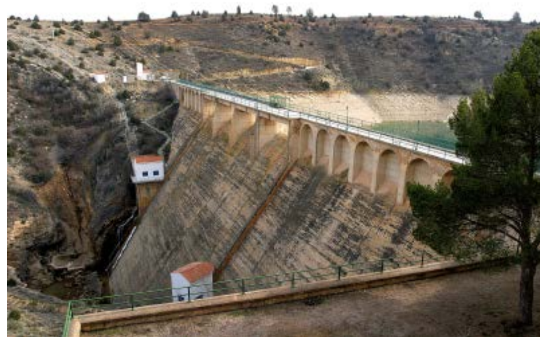
Presa del embalse del Arquillo FOTO JAVIER ROMEO-ARCHIVO PRAMES
